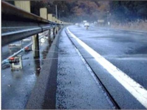
定置式溶液散布装置
